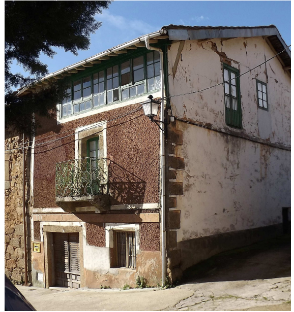
EJEMPLO 2: Modelo con galería parcial acristalada en la planta superior, con enfoscado oscuro poco habitual en la fachada principal, en contraste con el encalado de la fachada secundaria, por lo que probablemente sea bastante reciente.
