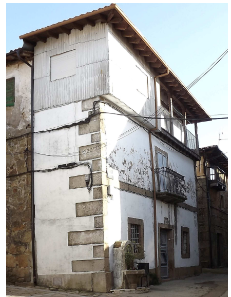
EJEMPLO 3: Ejemplar con galería que cubre aproximadamente la mitad de la planta superior en la fachada principal, con el resto macizo recubierto de placas impermeables que ocultan el entramado. Fábrica de piedra en las dos plantas inferiores, evidenciando un posible recrecido posterior.
