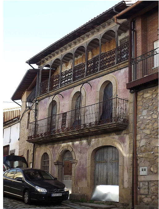
EJEMPLO 2: Composición seriada y ordenada, con empleo de elementos clasicistas, aunque incorpora, con intención compositiva, la galería semiempotrada superior propia de la arquitectura tradicional.
