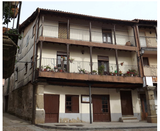
EJEMPLO 2: Ejemplar canónico de fachada ligera, sensación reforzada por el soportal, el cual se sostiene mediante un soporte metálico central muy de poca sección y reserva las pilastras de piedra para los extremos.
